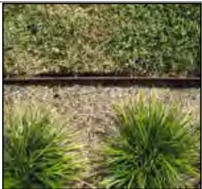
OS 008 Edge Detail Steel Edge
